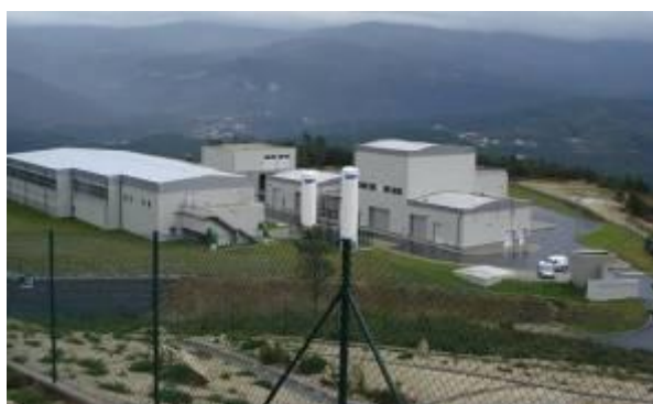
Figura 52 – Vista panorâmica da ETA de S. Jorge
