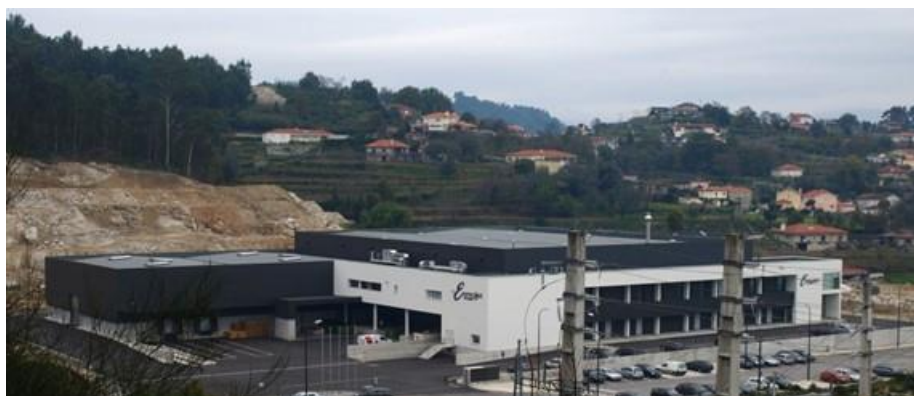
Figura 180 – Vista da zona de intervenção
