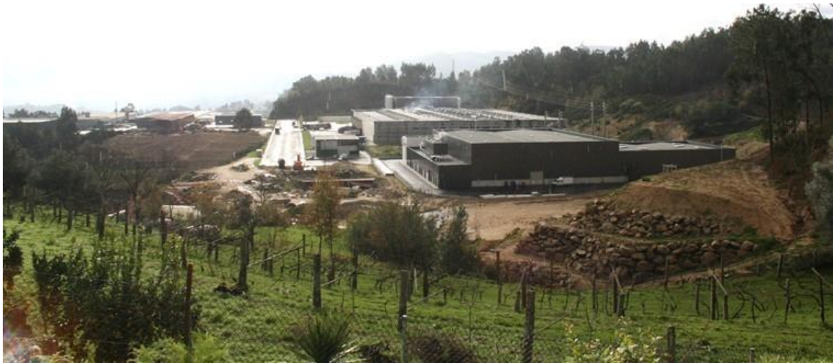
Figura 157 – Vista da Eurocast a partir de Norte
