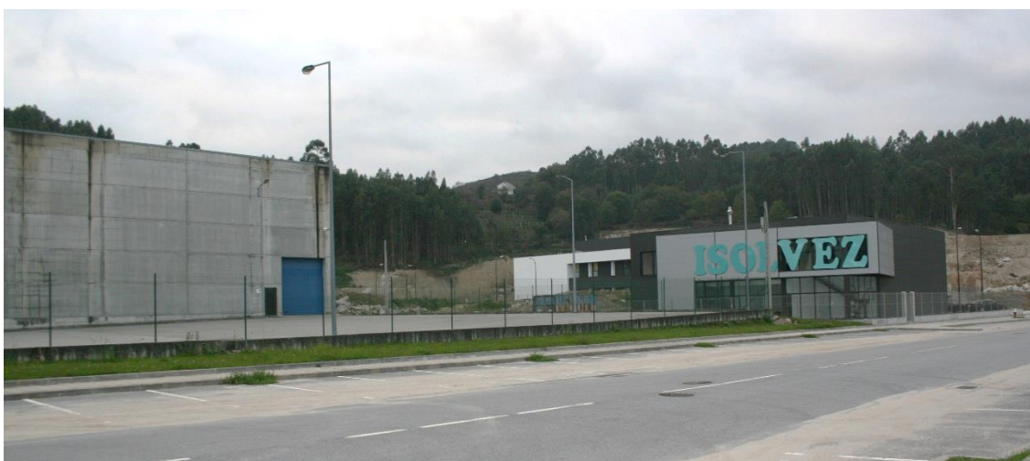
Figura 183 – Vista parcial do Parque Empresarial de Mogueiras
