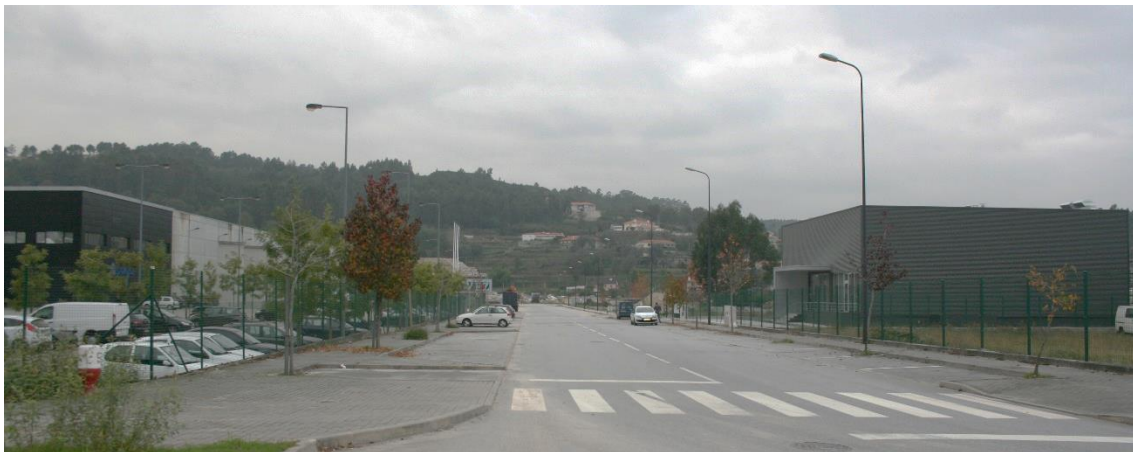
Figura 159 – Vista parcial do Parque Empresarial de Mogueiras
